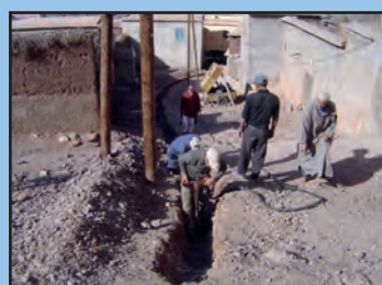
Excavation des tranchées
