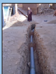
Mise en place des conduites
