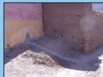
Raccordement d'une habitation
