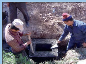
Fabrication d'un regard
