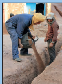
Remblaiement des tranchées
