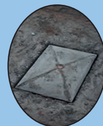
Trappe d'accès des regards
