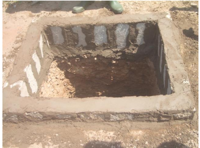
Scellement des briques béton de ceinture de fondation des fosses
