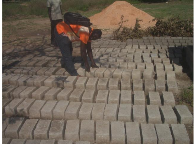
Réalisation des briques béton par les villageois
