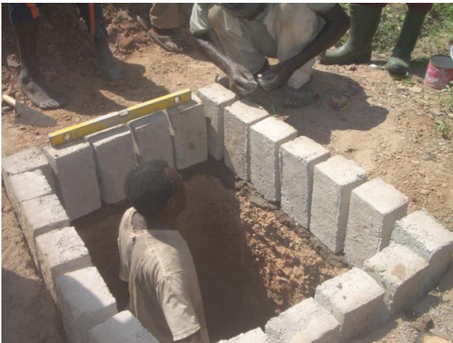
Pose des briques béton de ceinture de fondation des fosses
