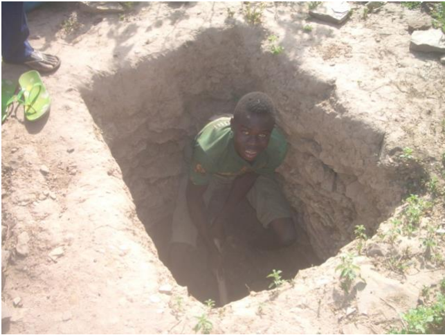
Creusement des fosses des latrines par les villageois
