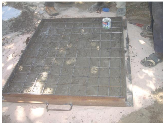
Moule pour réalisation des dalles samplat
